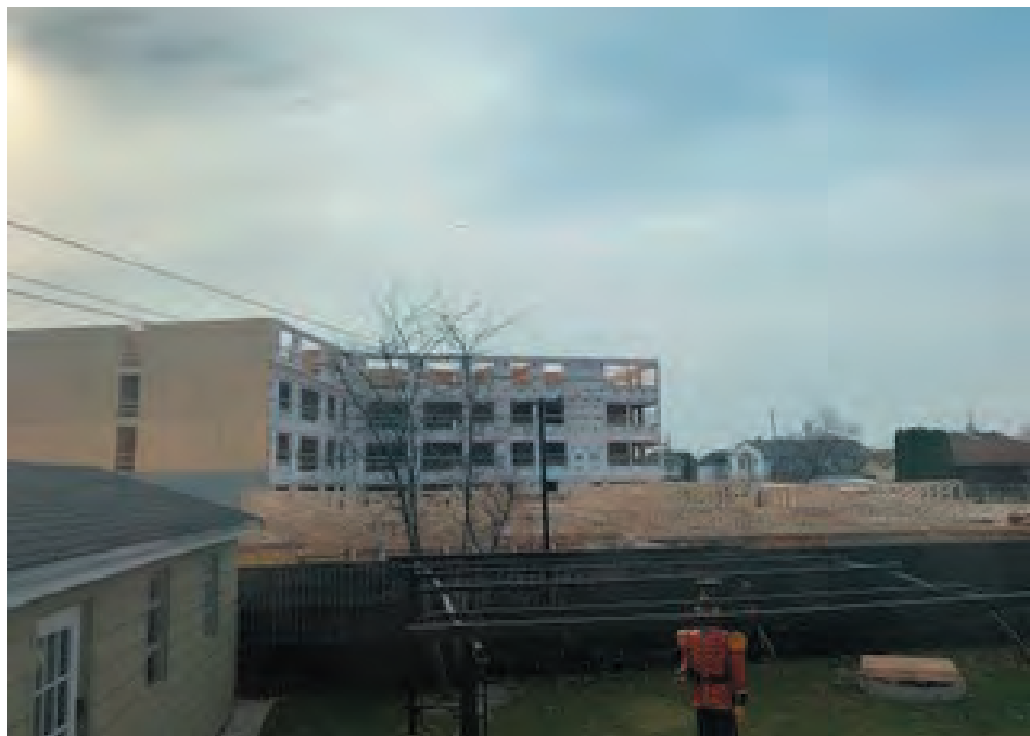
La vue directe sur la construction du site de construction Méridiem
