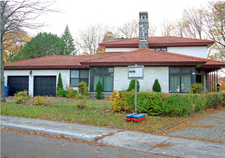
Pour la deuxième fois depuis 2019, le Comité d'étude des demandes de permis de démolition de VMR prendra en considération une demande de permis pour démolir cette maison au 159, avenue Balfour. (Photo d'archives: Martin C. Barry)
