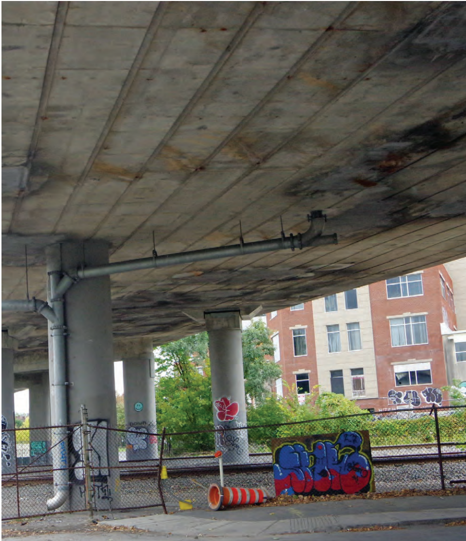
La Ville de Montréal envisage de démolir le viaduc Rockland pour le remplacer avec un passage souterrain, bien que la décision serait loin d'être prise et les travaux ne commenceraient qu'en 2028 au plus tôt.
